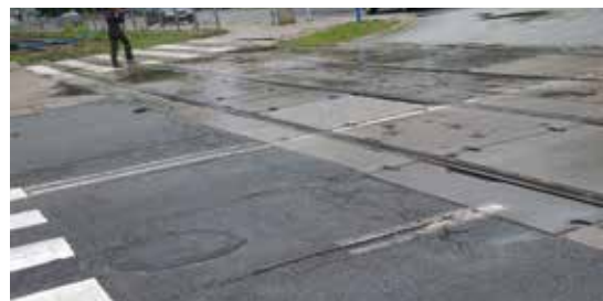
Widoczny fragment torów tramwajowych w ul. Żelaznej (skrzyżowanie z ul. Proszą), 2013 r. Fot. Jarek Zuzga
