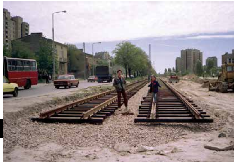
Budowa linii tramwajowej na Jelonkach, 1991 r. Fot. Antoni W. Szafrński / Cyfrowe Archiwum Bemowa
